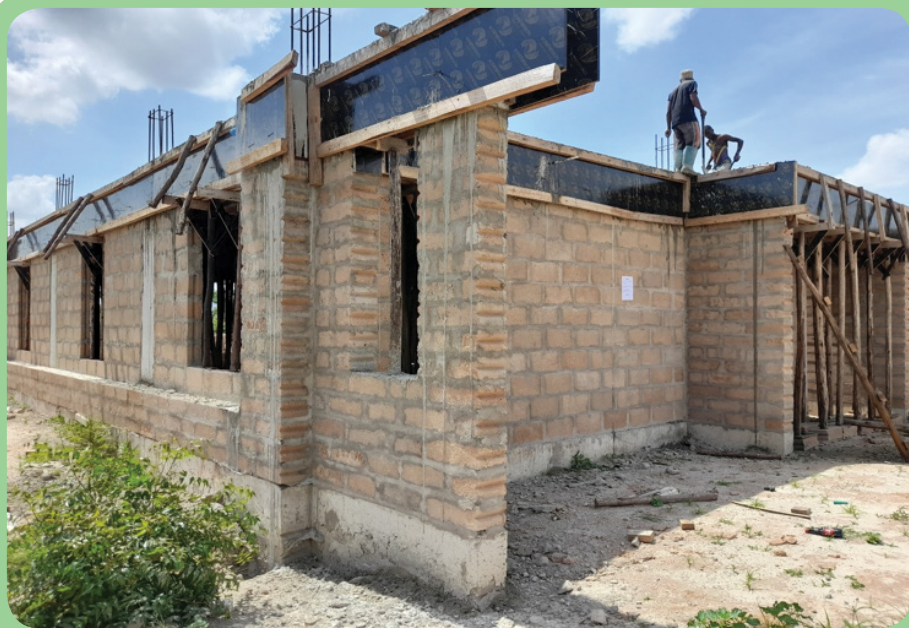
Ujenzi wa jengo la Maabara ukiendelea jijini Dar es Salaam.
