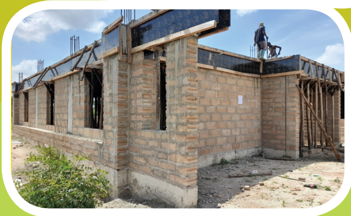
Ujenzi wa jengo la Maabara ukiendelea jijini Dar es Salaam
